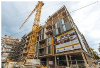
Außenaufnahme Rohbau / Bild: Philipp Liparski
